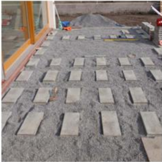
tömörített kavics ágy
